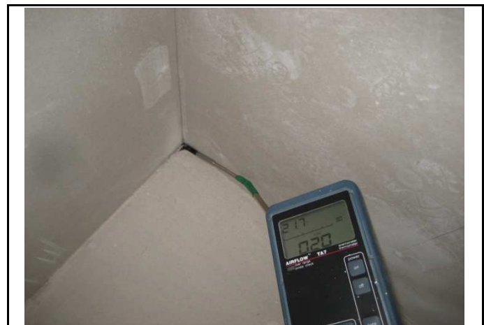
Nebīva konstrukciju mezgla vieta
