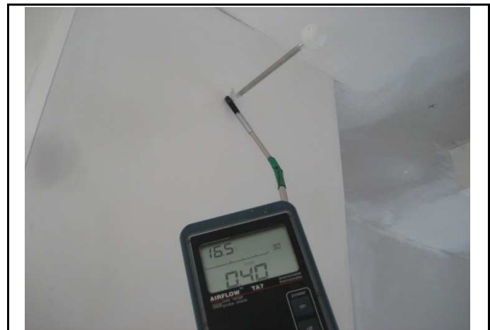
Gaiscaurlaidīga elektrokomunikāciju iebūves vieta
