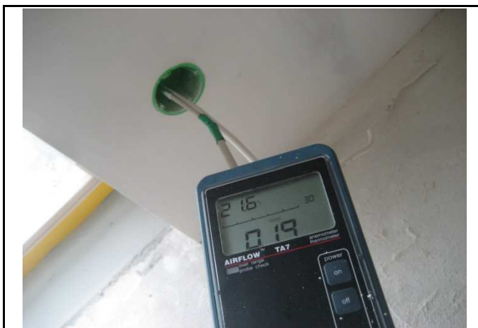
Gaiscaurlaidīga elektrokomunikāciju iebūves vieta
