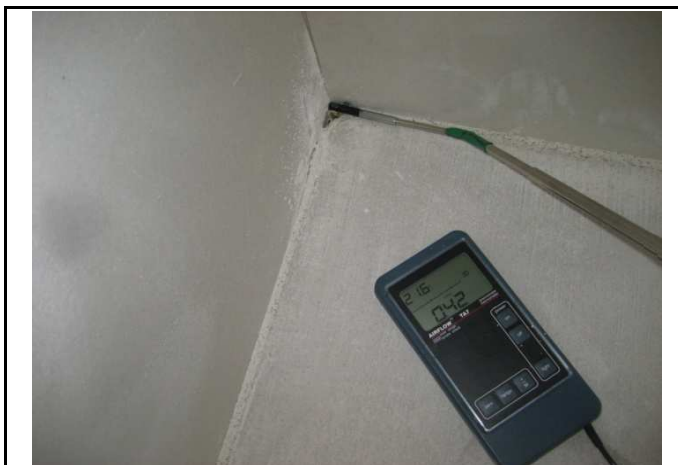
Nebīva konstrukciju mezgla vieta
