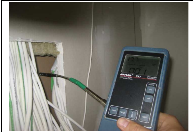
Blīva elektrokomunikāciju iebūves vieta
