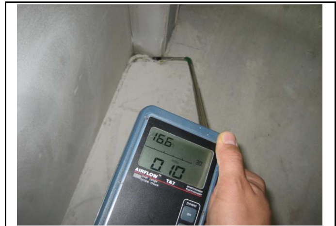
Nebīva konstrukciju mezgla vieta
