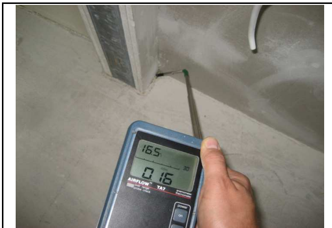
Nebīva konstrukciju mezgla vieta
