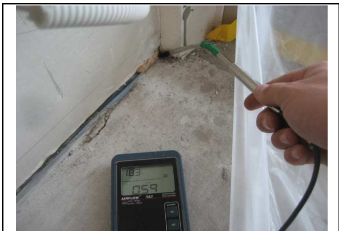
Nebīva konstrukciju mezgla vieta
