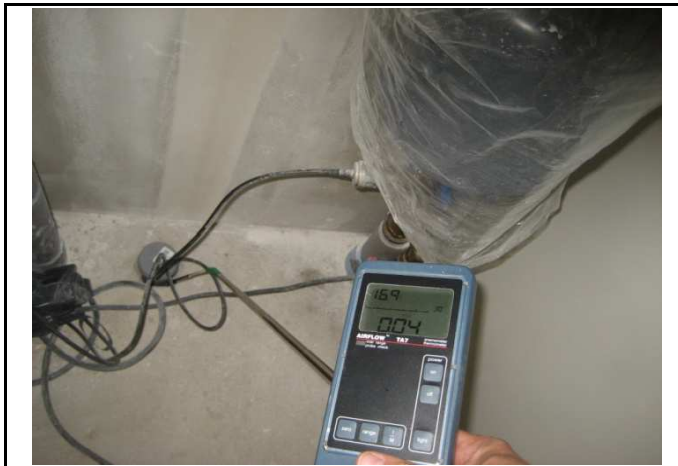
Blīva elektrokomunikāciju iebūves vieta
